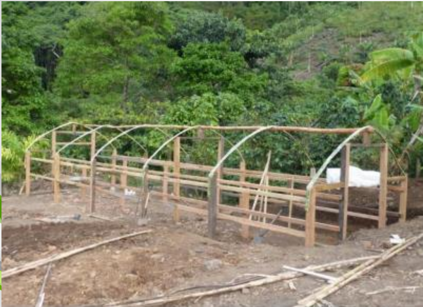
Figura 21. Vista secador solar con los arcos. Fuente: (Jordi Besora Magen).
