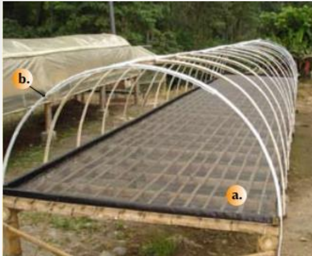
Figura 31. a) Piso en malla Sarán, b) Arcos que forman la estructura para soportar la cubierta plástica, reforzados en la parte interna y sujetos en la parte superior con el caballete.
