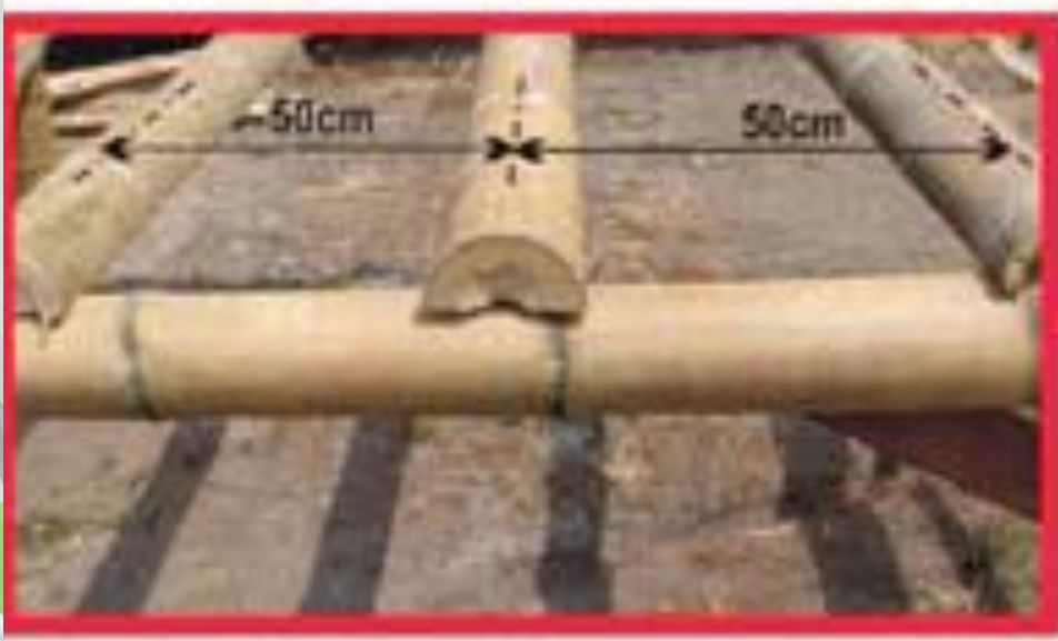
Figura 35. Detalles de distancia entre travesaños.
