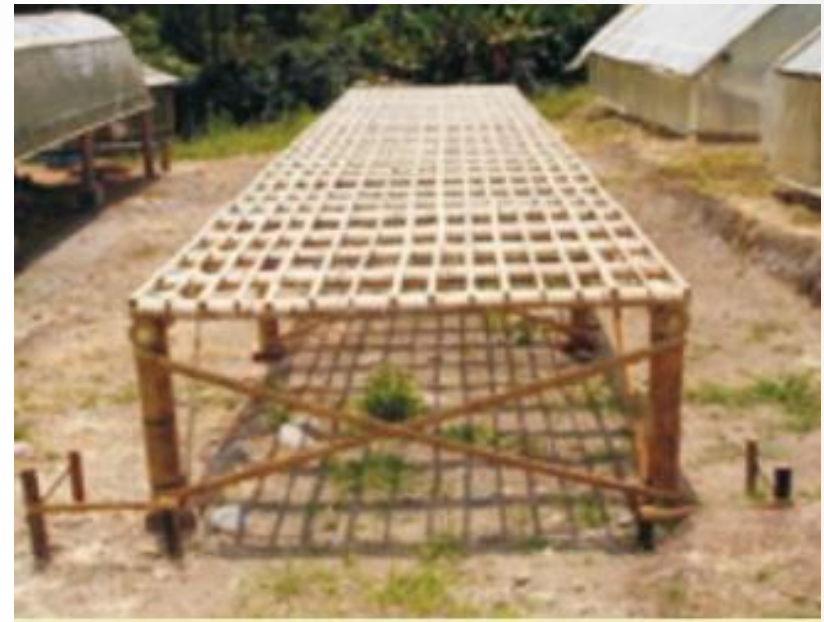
Figura 30. Detalles de la construcción del piso del secador.
