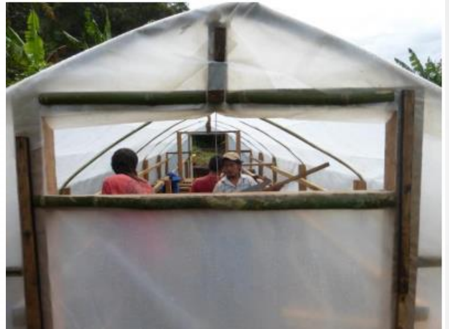
Figura 27. Vista exterior de la ventana.
