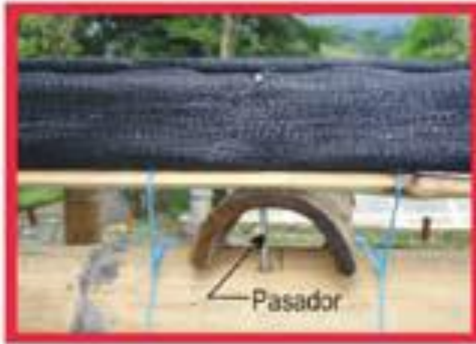
Figura 38. Fijación del marco al entramado.
