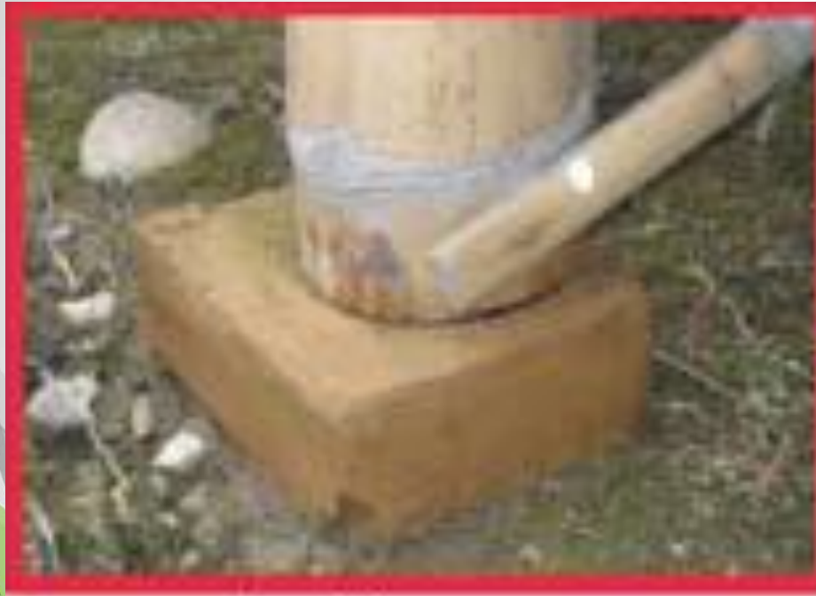
Figura 37. Base de ladrillo .
