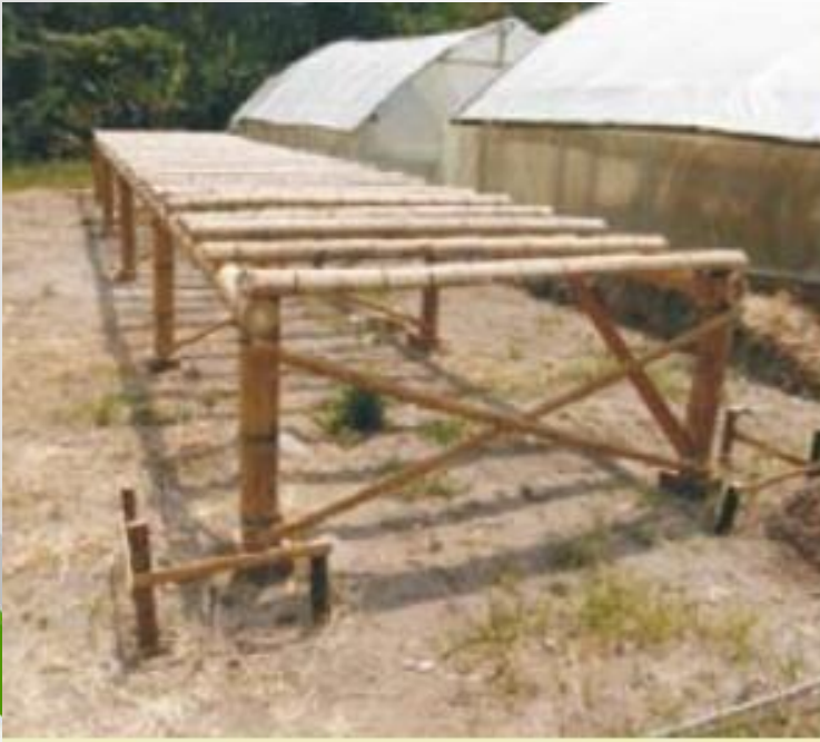
Figura 29. Demarcación del lote y ubicación de las columnas.
