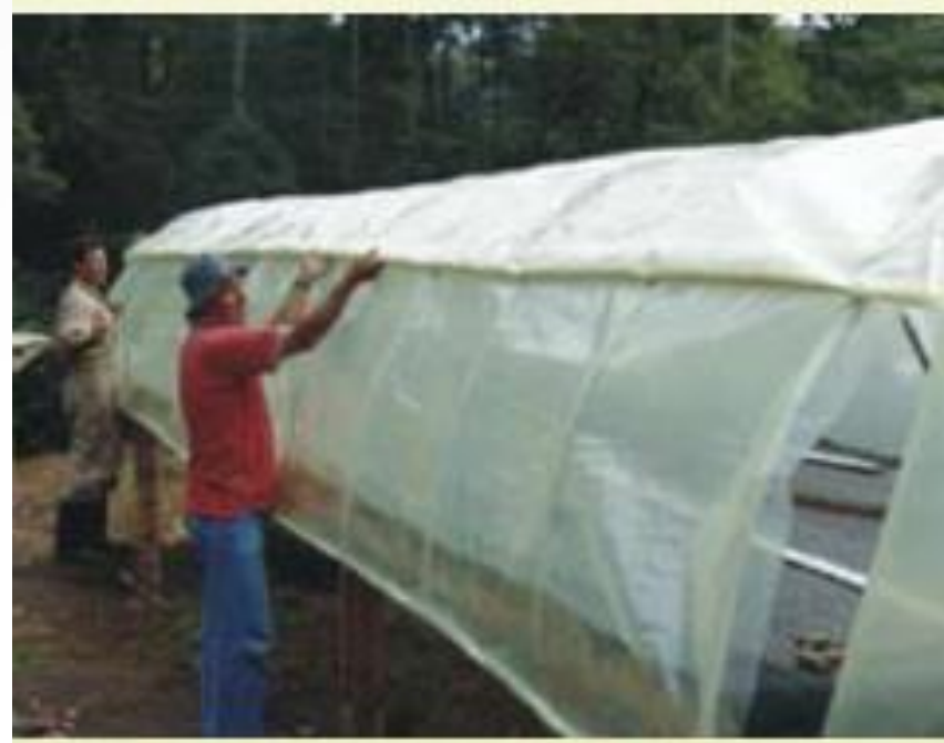
Figura 42. Cubrimiento y templado del plástico.
