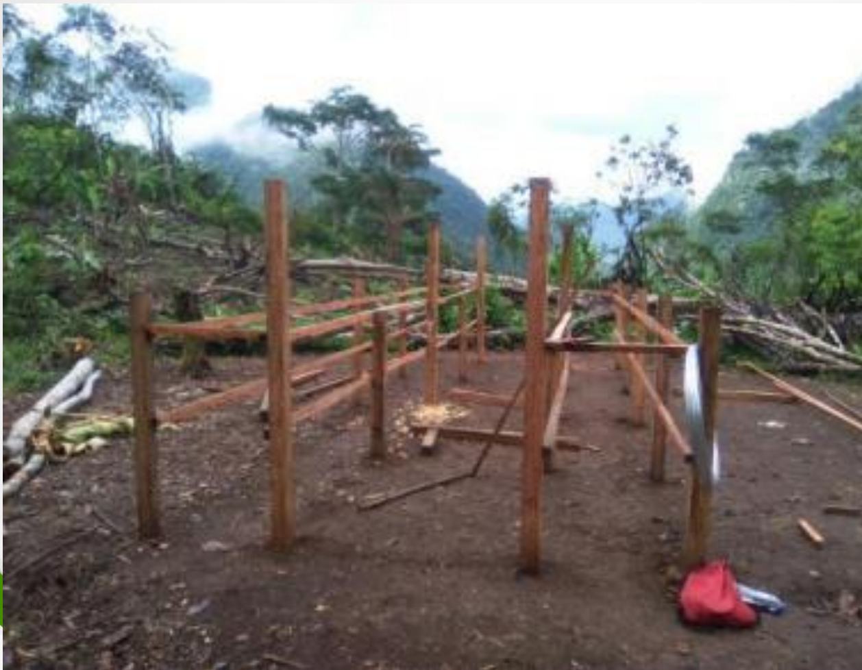
Figura 18 : Vista estructura secador solar. Fuente: (Jordi Besora Magen).
