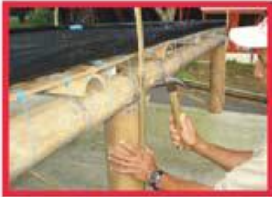
Figura 39. Fijación de los arcos.
