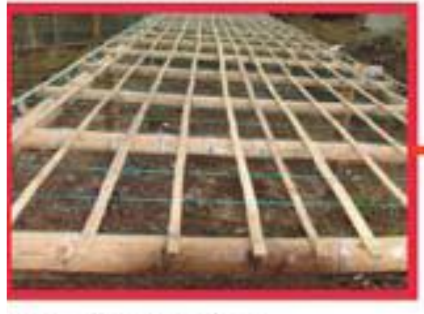
Figura 36. Entramado del piso
