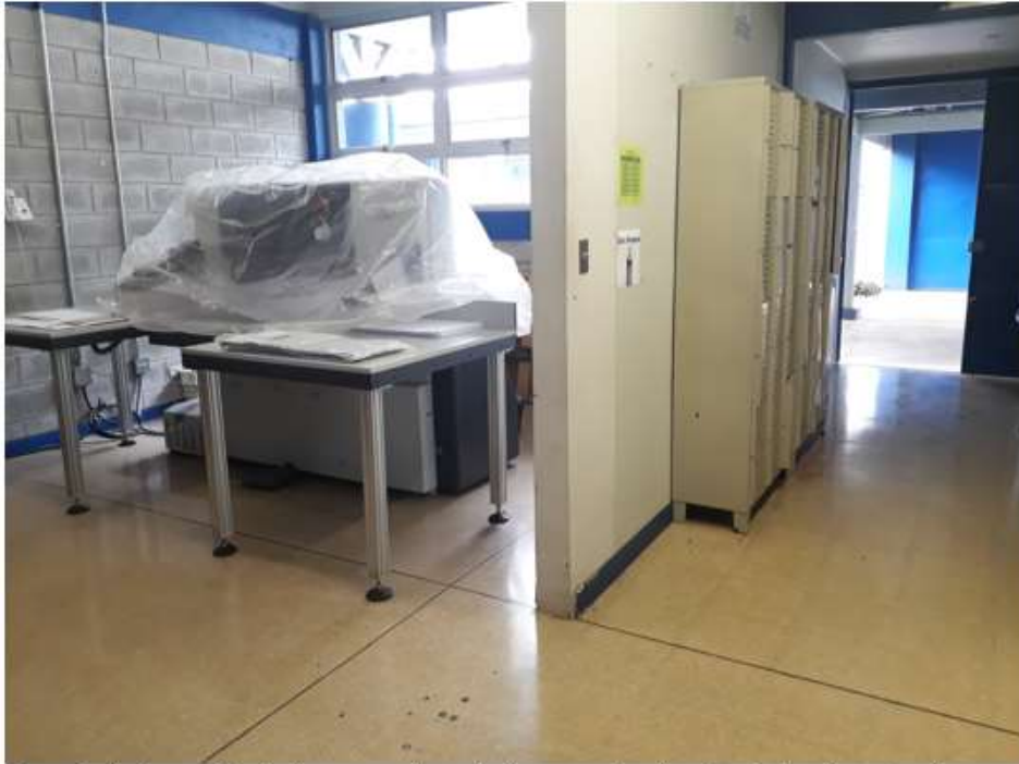
Zona de lokers y Guillotina, se colocará dispensador de alcohol en la entrada.
